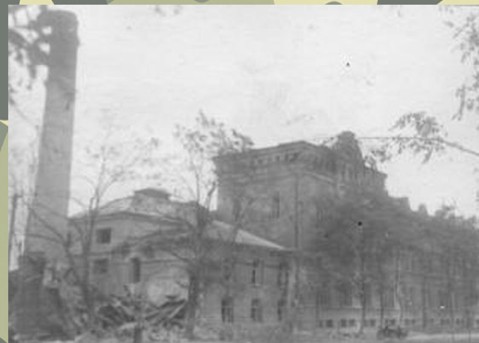
РАЗРУШЕННЫЙ ПРИ ОТСУП- ПЛЕНИИ НЕМЕЦКИХ ВОЙСК ЛИКЕРО-ВОДОЧНЫЙ ЗАВОД
